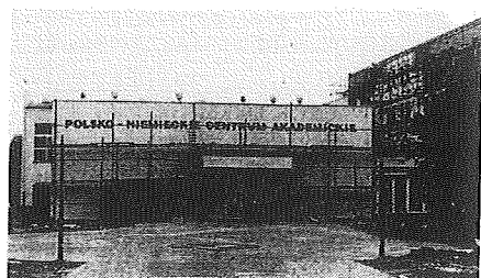
Elewacja wejściowa Centrum — stan w maju 1996 r.
