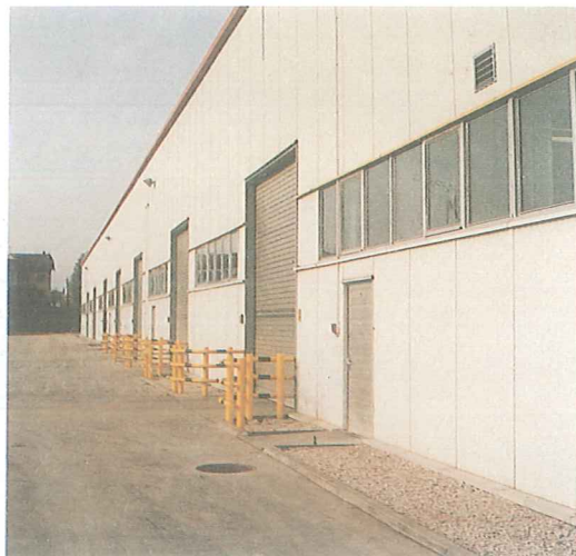
Rys. 7.4. Elewacja południowa — bramy rolowane typu Hörmann, żółte odbojnice (fot. R. Ast, 1995)
