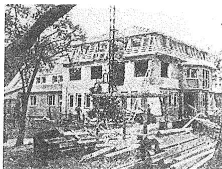
Budowa dachu mansardowego nad stołówką, w kubaturze którego przewidziano pokoje hotelowe
