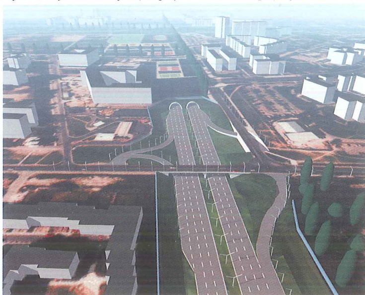
Rys. 5.10. Wylot autostrady ku dolinie Wisły oraz węzeł z ul. Jana Rosoła. Istniejące zainwestowanie uniemożliwiło wykształcenie pełnej „koniczyny”
