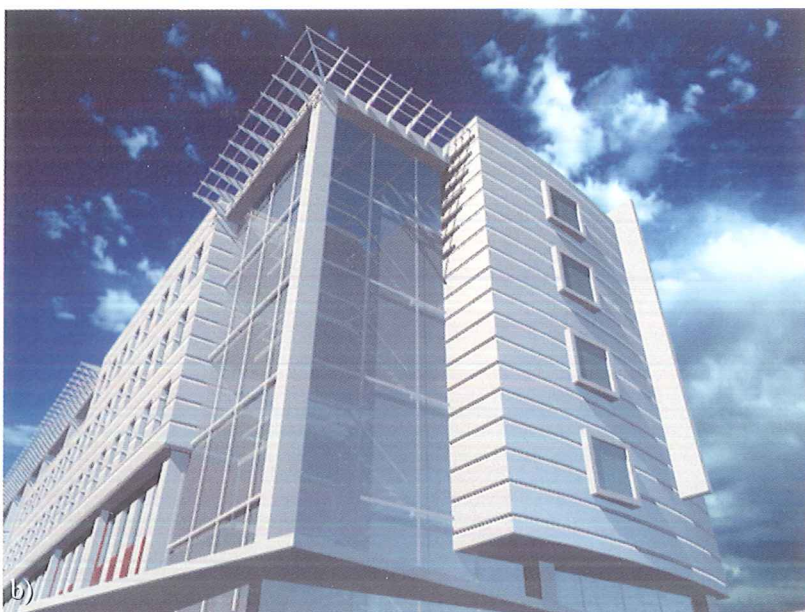
Rys. 6.34. Sześciokondygnacyjny obiekt miałby spełniać funkcje usługowe (parter), budynku użyteczności publicznej (I i II piętro) oraz wyższej uczelni (IV–VI piętro). Fragmenty budynku przeznaczone dla tych funkcji oddziela niezależny system klatek schodowych i wind. Pod obiektem zaplanowano parking podziemny połączony z podziemnym kompleksem parkingów planowanym w okolicy
