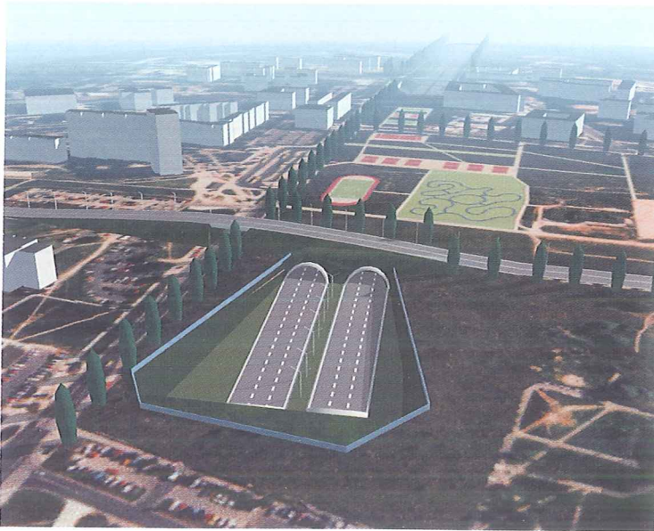
Rys. 5.8. Węzeł przy ul. Komisji Edukacji Narodowej tworzą: ulica na powierzchni, autostrada oraz planowana trasa metra na najniższym poziomie. Z tego powodu autostrada na tym odcinku „wynurza” się na powierzchnię terenu. Jest to korzystne również ze względów wentylacyjnych i bezpieczeństwa
