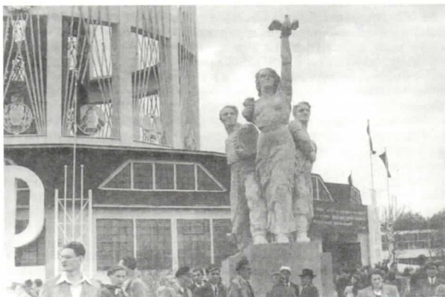
3. Wieża Górnośląska z okresu socrealizmu 3. Upper Silesian Tower from socialist realism period
